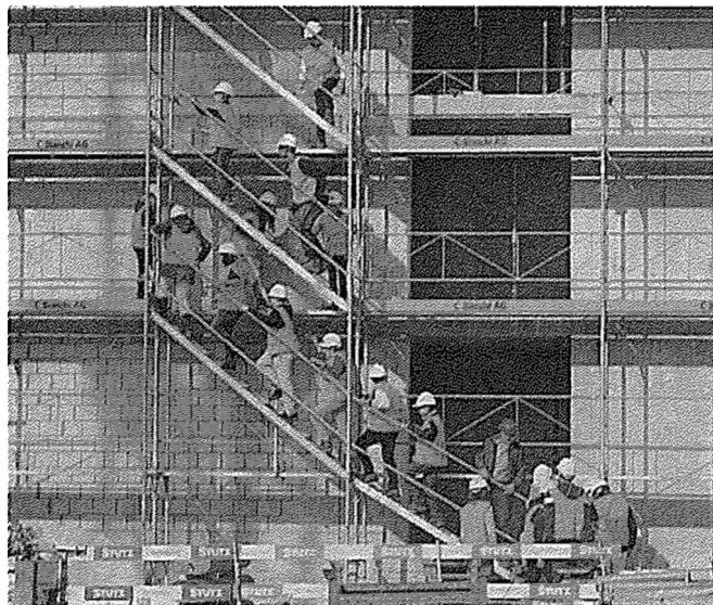
Die Schüler steigen auf das Gerüst der Baustelle.
